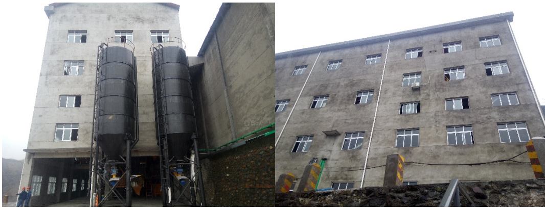
砷碱渣无害化处理工程项目整体外观
