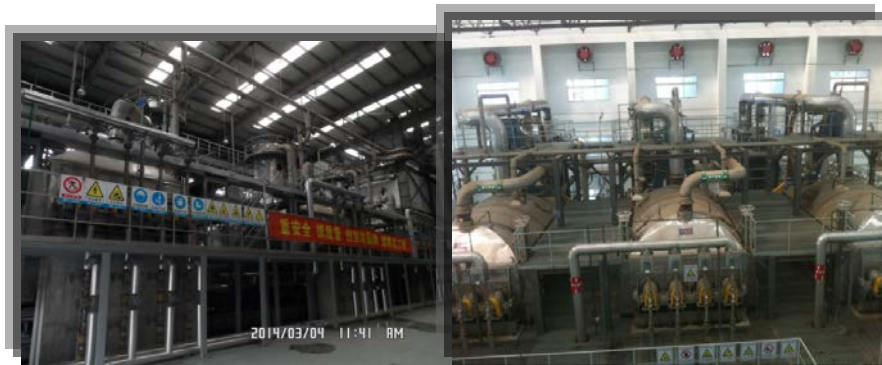
图 3-3 佛山市南海区污泥处理项目
