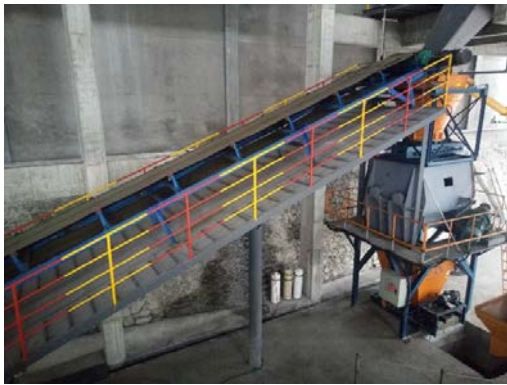
含砷废渣皮带进料系统
