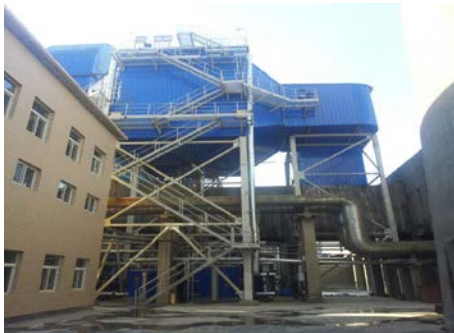
100MW 示范工程现场照片图
