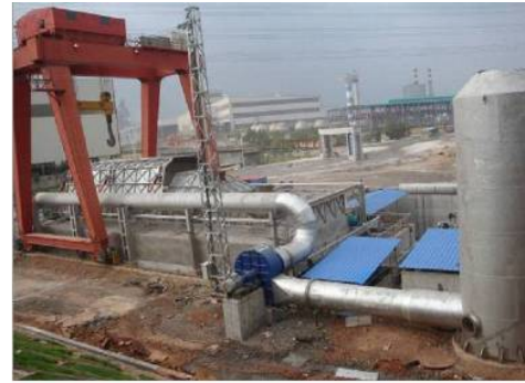
钢渣有压热闷半工业生产线
