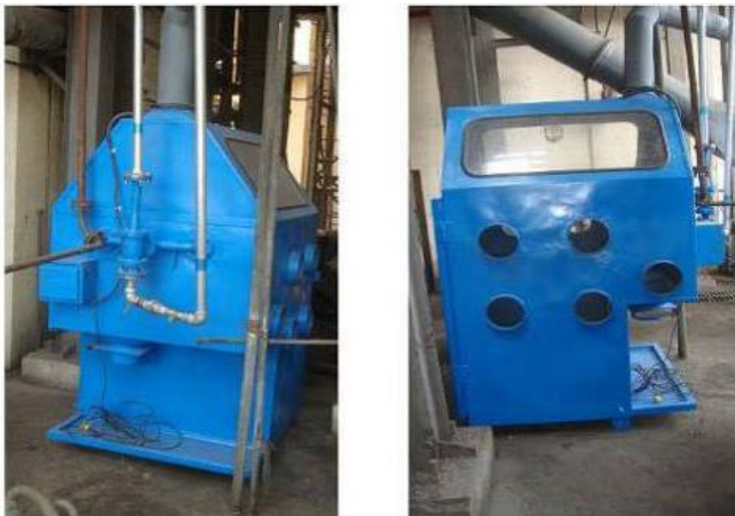
图4-1 粉末状高纯农药类危险废物真空进料装置现场安装图
