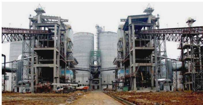
九江钢铁渣“零排放”产业化基地及钢铁渣粉生产线示范工程
