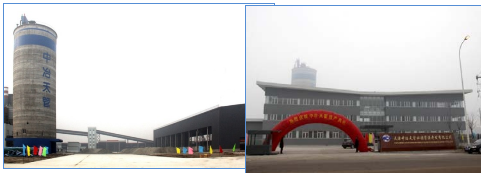
天津钢铁渣粉产业化基地（矿渣粉生产线局部）
