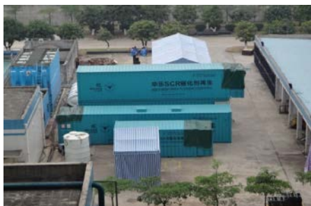
SCR 脱硝催化剂再生改性生产线
