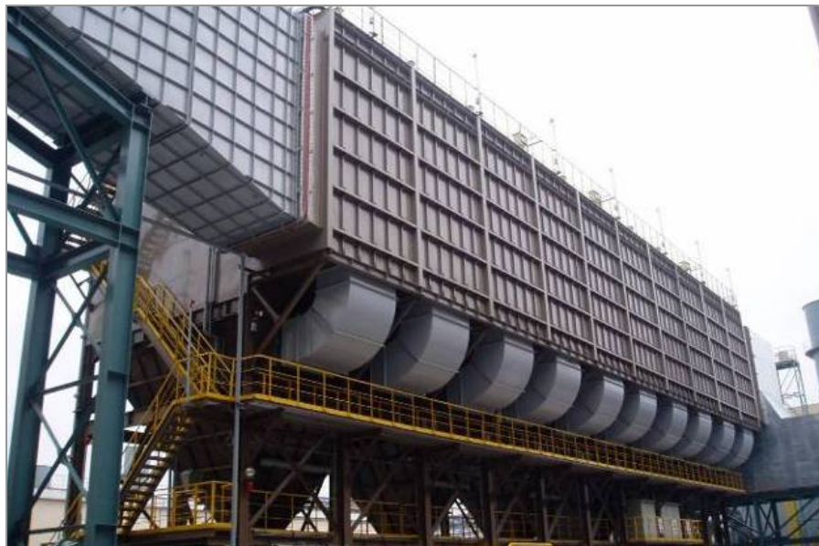
高效低阻脉冲袋式除尘技术在宝钢的工程应用
