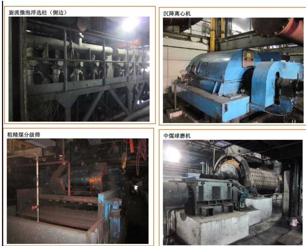
图 7 基于中煤再选的高灰难选煤泥高效分选技术工业现场照片
