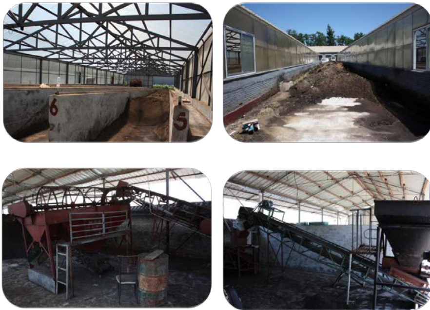
图 3 畜禽粪污区域集约化治理示范工程
