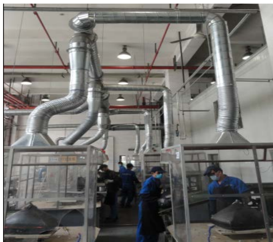
图 3-43 可移动式拉伸的吸风装置
