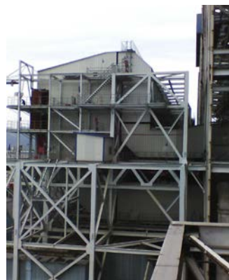
600MW 燃煤锅炉 SCR 脱硝工程
