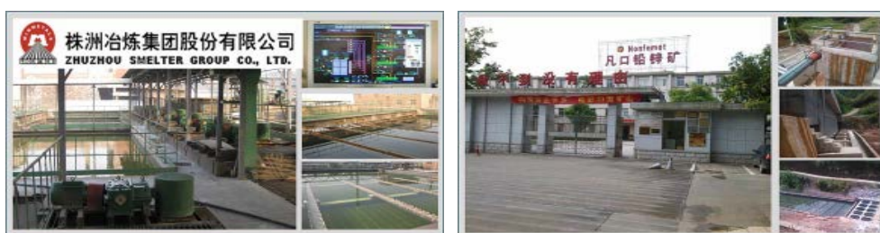
图 4-1 重金属废水深度处理与回用示范工程现场（株冶集团 14400m 3 /d 及凡口铅锌矿（8000m 3 /d）废水工程）
