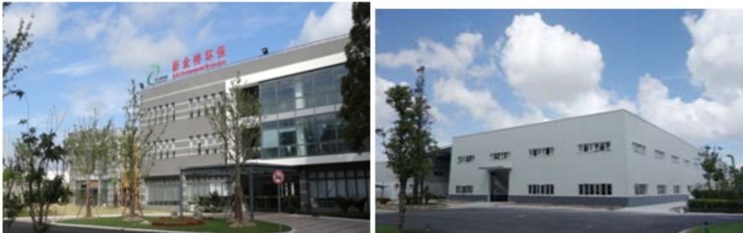
图 3-46 研发大楼图及中试车间
