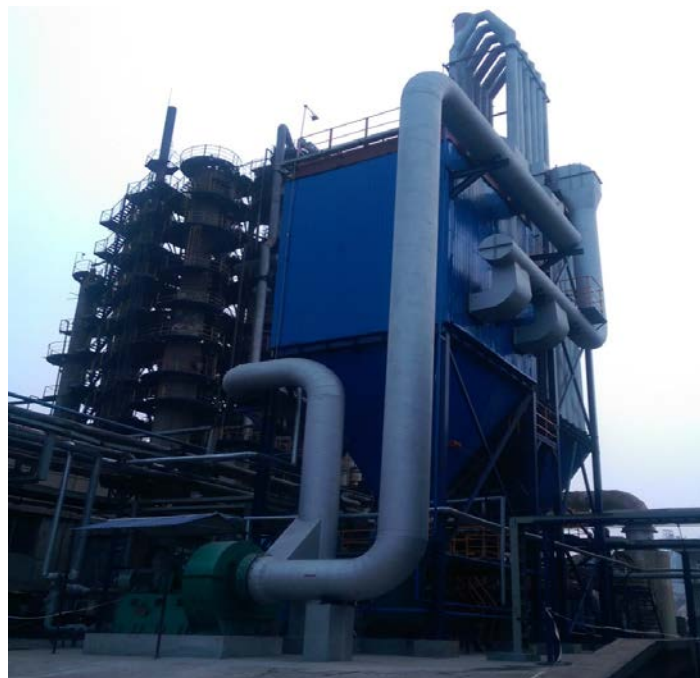
蓝星石油有限公司济南分公司石化催化裂化再生烟气治理示范工程
