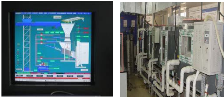
图3-17 焚烧处置自控系统中试研究平台
