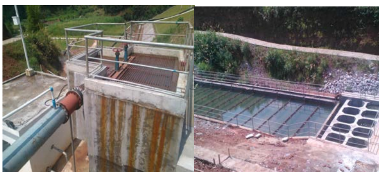
图 4-3 尾矿库外排水处理现场情况
