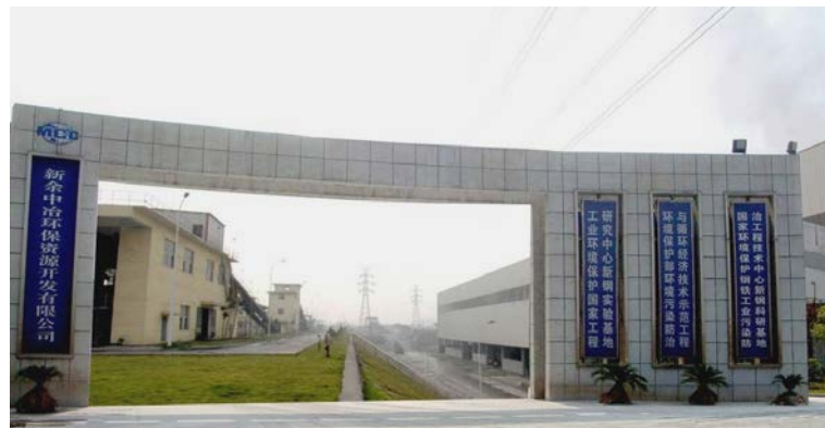
新余钢渣“零排放”示范工程及产业化基地
